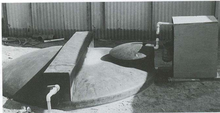
Fig. 11.17. Cisterna de 2.500 galones con bomba a la derecha. (Cortesía de California Watercress, Inc., Fillmore, CA).
