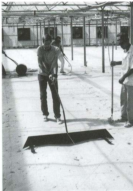
Fig. 10.11. Inclínación del suelo para proporcionar el drenaje entre cada dos líneas de planchas.
