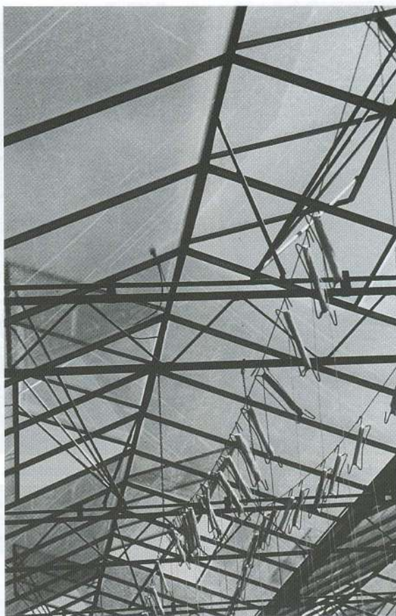
Fig. 10.53. Los respiraderos en cresta proporcionan una ventilación natural. (Cortesía de Houweling Nurseries Oxnard, Inc., Camarillo, CA).
