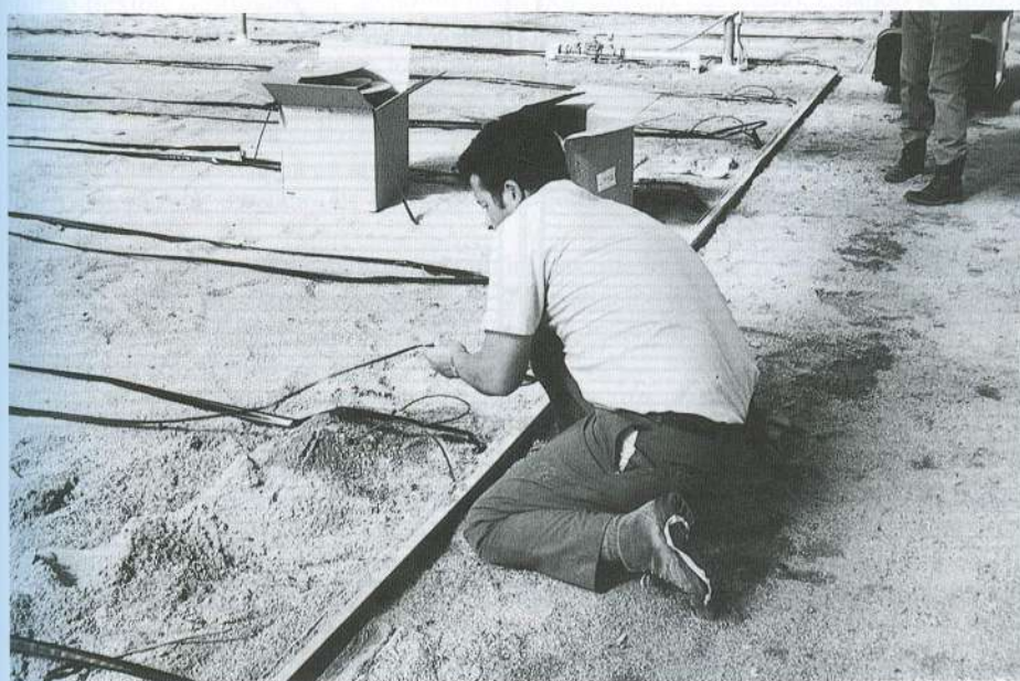
Fig. 8.9. Instalación de las tuberías de rezume en un sistema automático de riego. (Cortesía de Superior Farming Company and the Environmental Research Laboratory, Tucson, Arizona).
