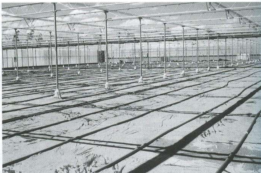
Fig. 8.7. Fondo de polietileno y tuberías de drenaje. (Cortesía de Superior Farming Company and the Environmental Research Laboratory, Tucson, Arizona).
