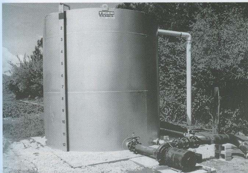
Fig. 6.72. Compresor para aumentar la presión del agua de la tubería de 8 pulgadas que sale del tanque de 10.000 galones, que es llenado con agua de un pozo. (Cortesía de California Watercress, Inc., Fillmore, CA).
