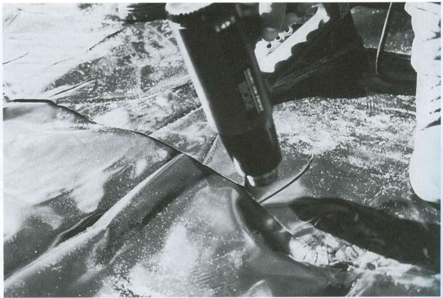
Fig. 6.69. Fundición de las juntas de polietileno con una pistola de calor. (Cortesía de California Watercress, Inc., Fillmore, CA).
