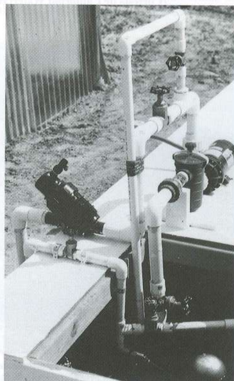
Fig. 6.89. Tanque de nutrientes con bomba de circulación, filtro a la izquierda y válvula flotante para llenado automático del tanque. (Cortesía de California Watercress Inc., Fillmore, California).
