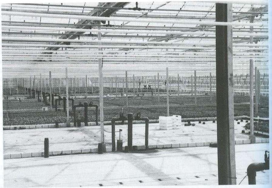
Fig. 6.62. Sistema de flujo y reflujo con suelo de hormigón para el cultivo de trasplantes. Obsérvense los lados de ladrillo de las bancadas y la ligera pendiente hasta el canal central de llenado y drenaje. (Cortesía de Bevo Farms Ltd., Langley, B. C, Canadá).
