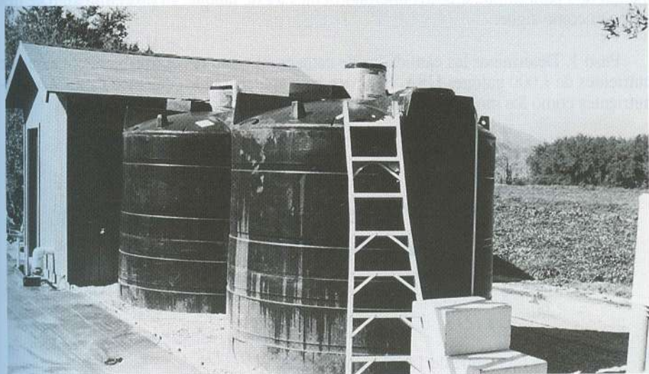
Figura 3.8. Tanques de stock de 2.300 galones con cobertizo para el inyector. (Cortesía de California Watercress, Inc., Fillmore, CA.).
